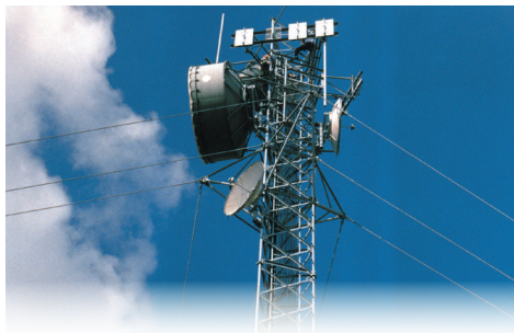
Transmisión eléctrica Electrical Transmission
